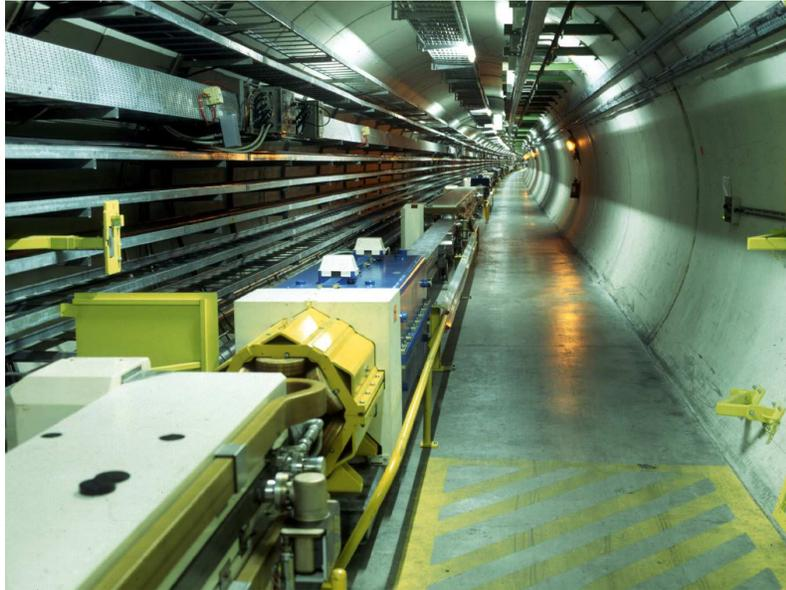
1250 supraleitende Dipolmagnete mit 1.6 Mrd. km supraleitendem Kabel ( $\approx 2 \times$  Erdumlaufbahn um die Sonne)
